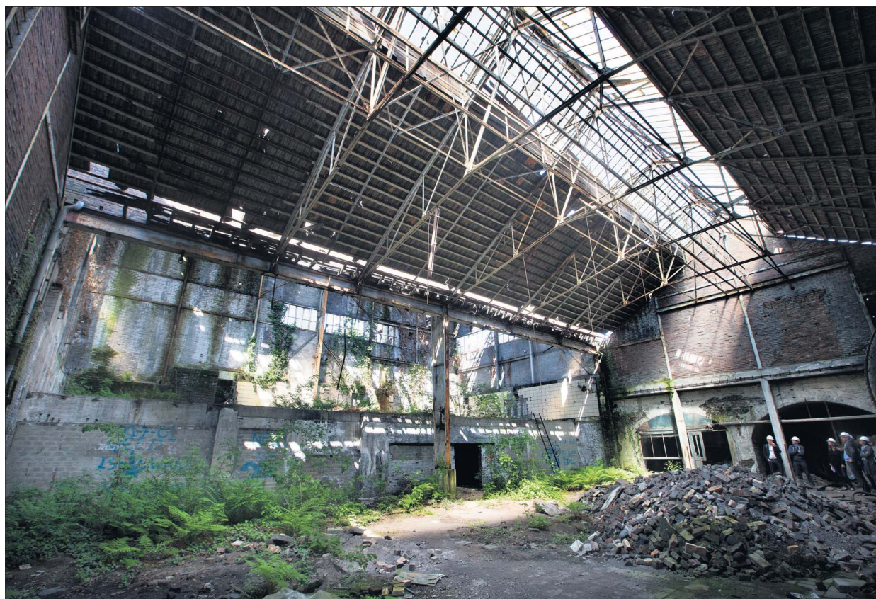
In deze industriële ruimte - de twee voormalige ketelhuizen - worden de filmzalen van Lumière ingepast als dozen. Links de oude elektriciteitscentrale, waar de foyer in wordt gevestigd.
